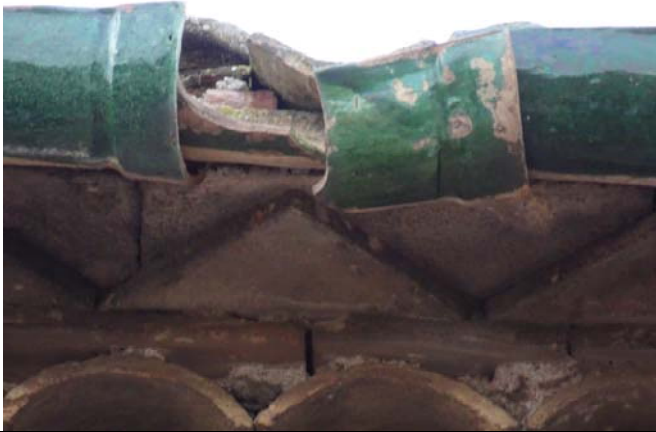
Gouttière en terre cuite, menaçant de s'effondrer sur la chaussée
