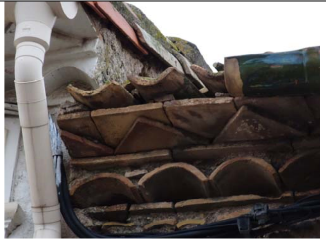
Risque de chute de tuiles par glissement
