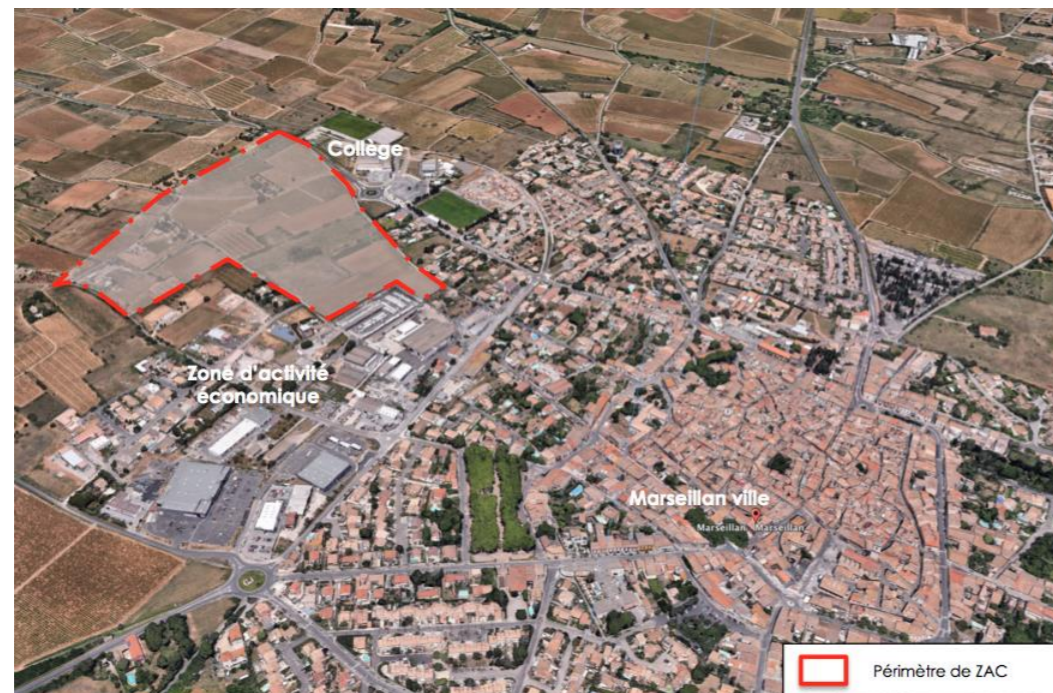
☞ Carte 3 : Localisation de la zone d'étude sur photo aérienne.
