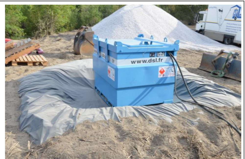
☞ Photographie 37 : Mise en place d'une aire étanche autour d'un groupe électrogène
