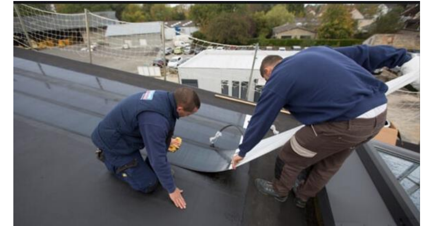
Photographies 1 & 2 : Mise en place de membrane photovoltaïque (Sources : TALEV et Concept YRYS)
