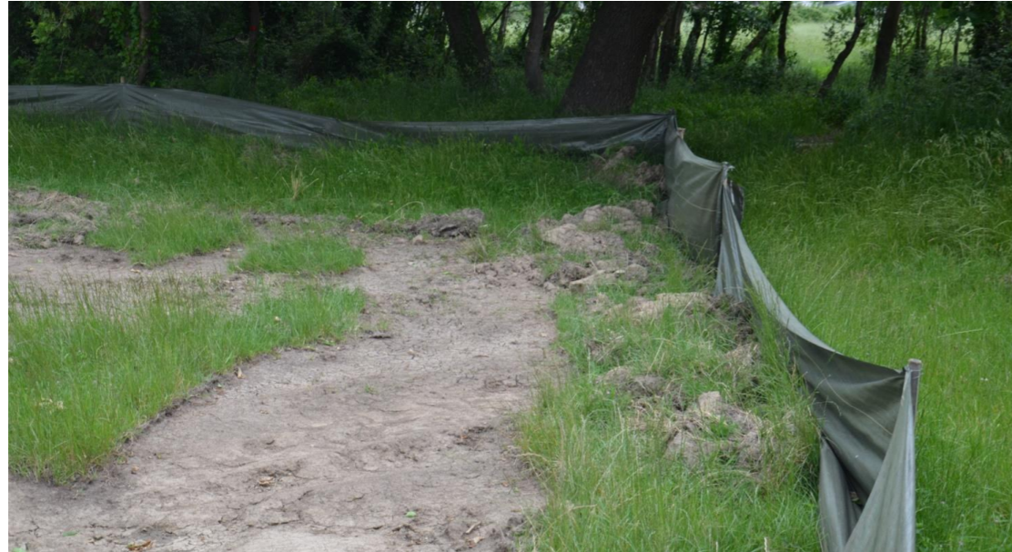
☞ Photographie 38 : Dispositif anti-intrusion/amphibiens (mis en défens d'une mare sur Argelès-sur-Mer, CRBE)
