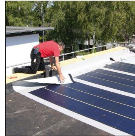
Photographies 1 & 2 : Mise en place de membrane photovoltaïque (Sources : TALEV et Concept YRYS)
