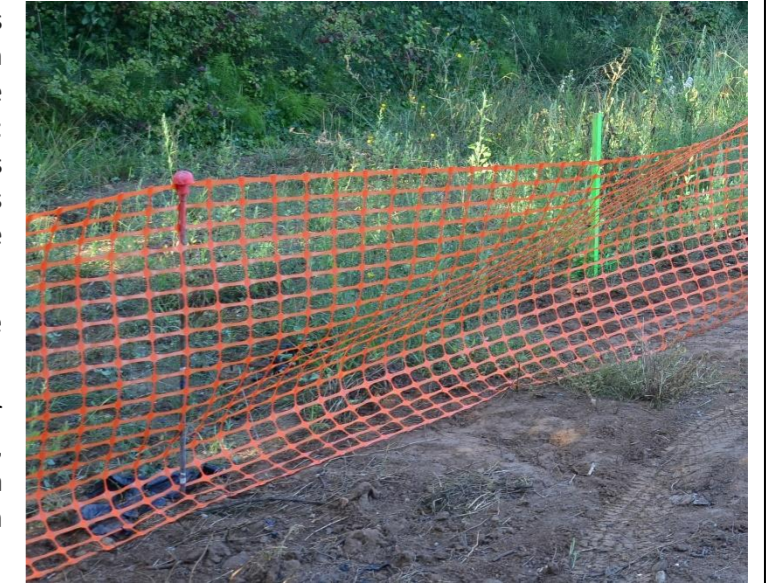
☞ Photographie 39 : Dispositif de limitation des emprises des travaux
