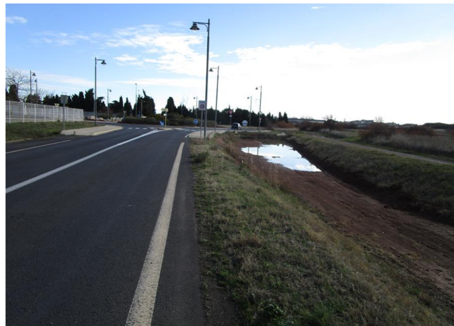
☞ Photographie 19 : Vue de l'entrée de Marseillan depuis la RD 32E8
